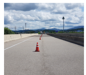
(b) 시공 후
