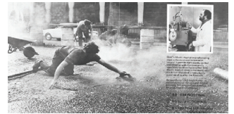
그림 2. 수작업에 의한 구스아스팔트 포장
