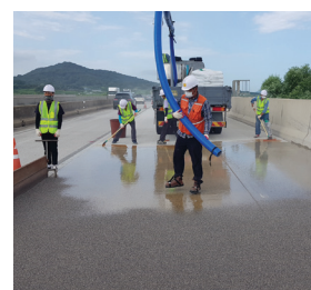
(a) 시공 중
